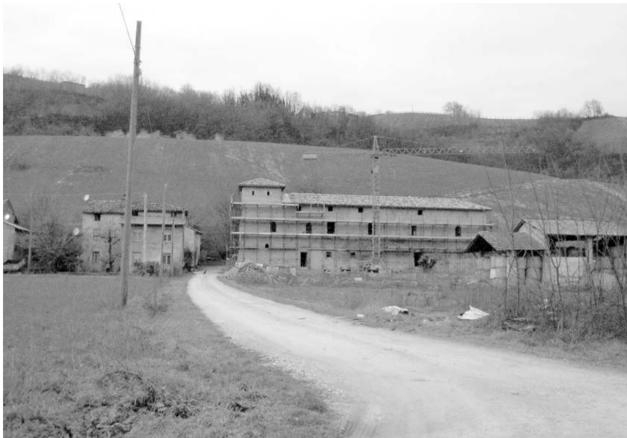
La struttura a Torricella di Chiavenna Rocchetta dove verrà collocato il centro visite della riserva geologica
